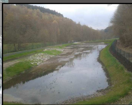
Flutmulde herstellen Gelände Absenkung Absenkung Uferrandstreifen
