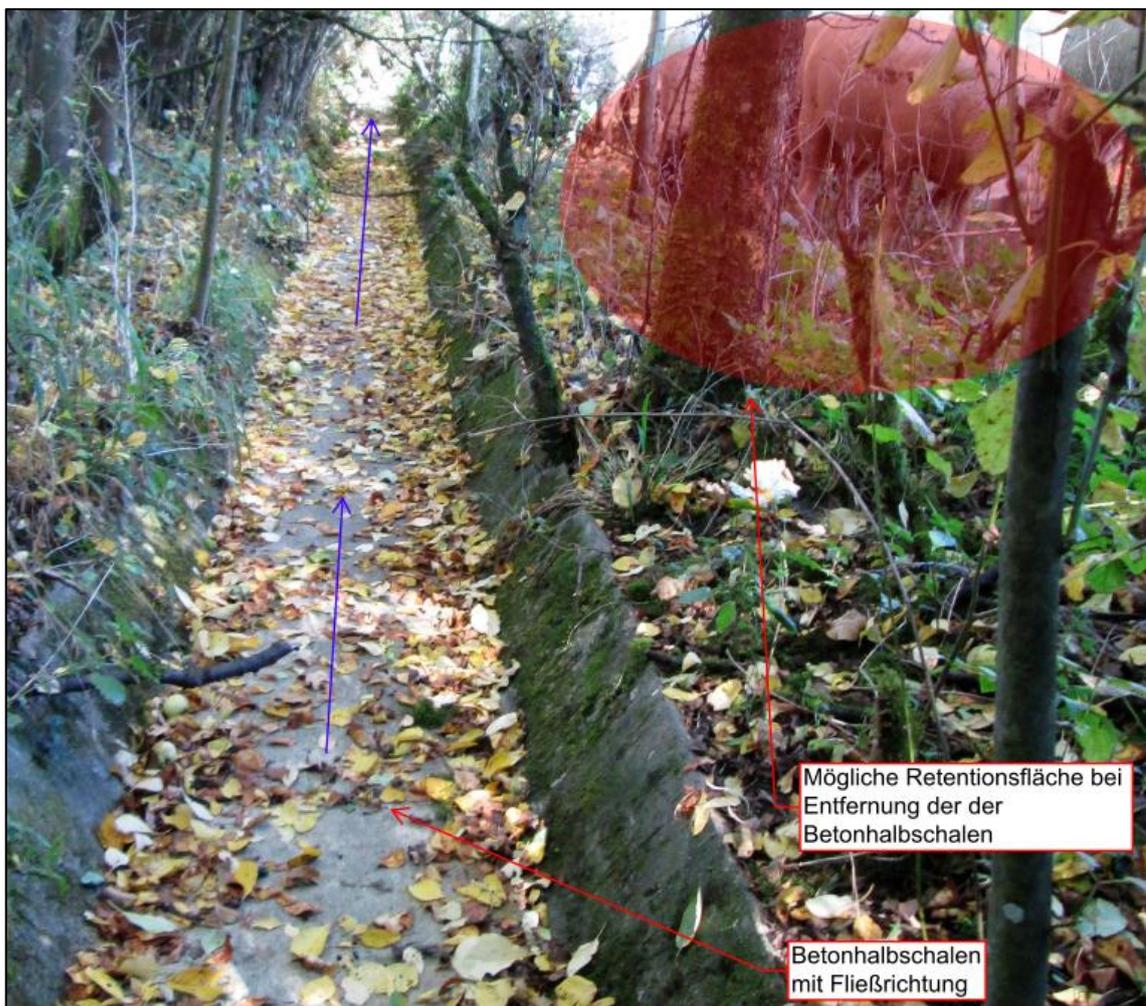
Abbildung 6-12 Betonhalbschalen an der B257
