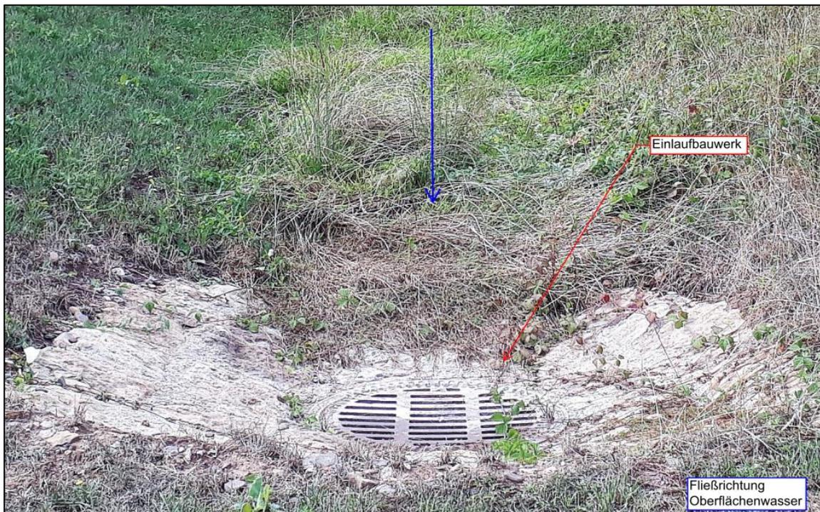
Abbildung 6-23 Einlaufbauwerk zur Entwässerung des Oberflächenwasser "In der krummen Furch"
