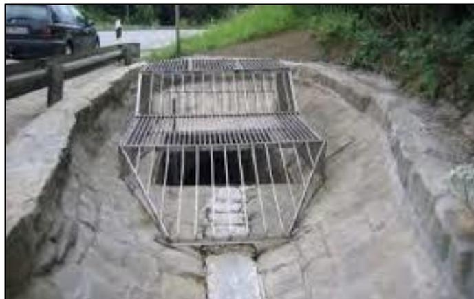
**Abbildung 6-5 Beispiel Einlaufbauwerk mit optimaler Rechenanlage Bildquelle: Stadt Hagen**
