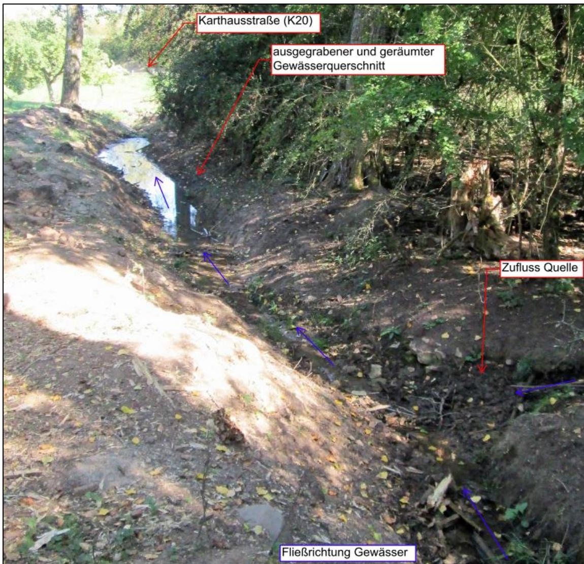
Abbildung 6-14 Ausgegrabener und geräumter Gewässerabschnitt „Im Grund“
