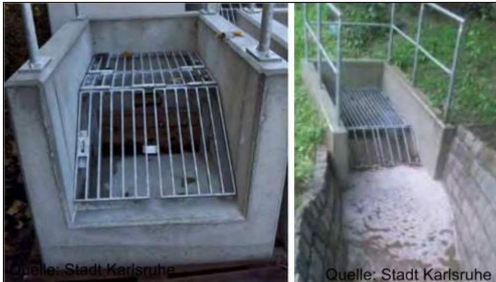
Abbildung 6-18 Beispiel Einlaufbauwerk mit Geröllfang als Fertigteil
